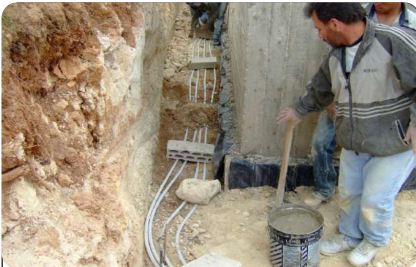
(١٥) تمديد أنابيب نظام الطاقة الحرارية الجوفية
