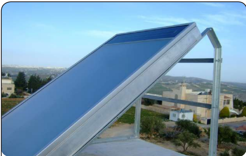
(٣) جهاز تسخين الهواء بالطاقة الشمسية
