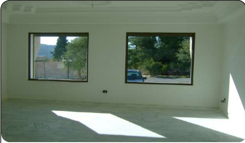
صورة (٣٣) : نوافذ ثابتة في جدران بناء أخضر
