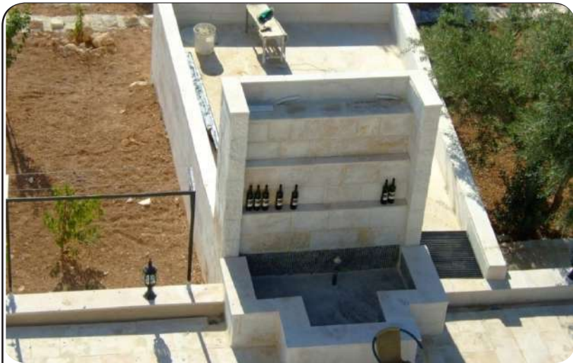
(١) بئر تجميع مياه أمطار ونافورة
